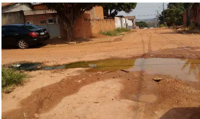
Figura 2: Vias sem pavimentação e drenagem pluvial.
